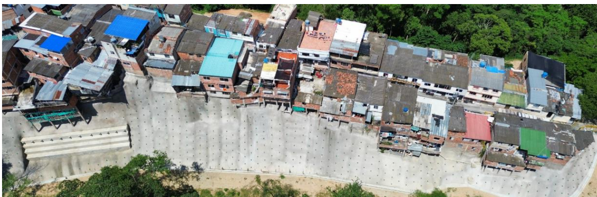
Pantalla Anclada que contiene 1054 anclajes de 15.00 m de profundidad, interviniendo 4.172,00 M2
