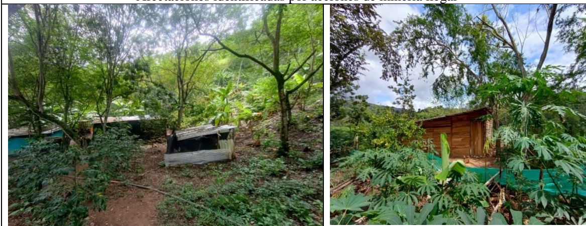
Construcciones ilegales dentro del predio de la CDMB
